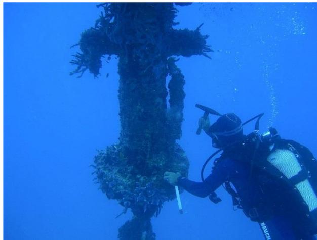
Figure 15 : Inspection des infrastructures par un plongeur.
